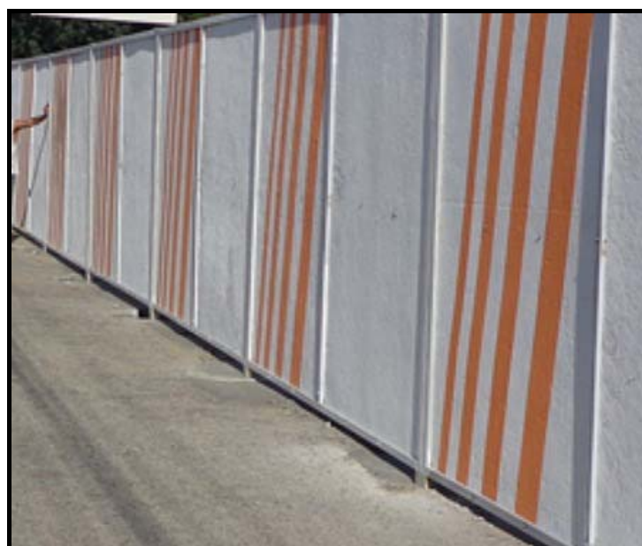
Figura 02 – Tapume de Compensado h=2,00m
